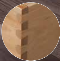
Schubladen schwalben- schwanzgezinkt
